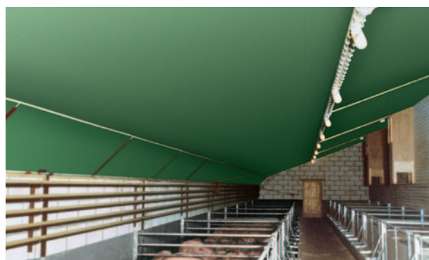
Fig. 3: Isolamento di una stalla.
