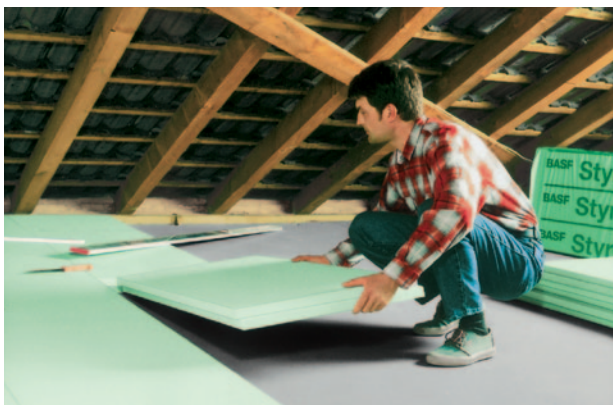
Fig. 4: Isolamento di un solaio con Styrodur® C.
