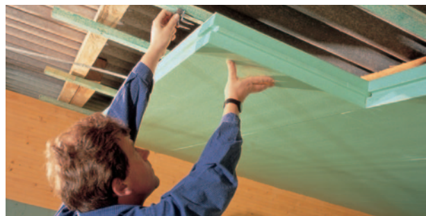
Fig. 7: Installazione di lastre in Styrodur C.
