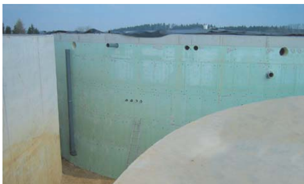
Fig. 1: Isolamento termico con Styrodur® C di una parete di fermentatore in calcestruzzo armato.
