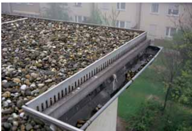
Fig. 7: Tetto con ghiaia su Styrodur® C.
