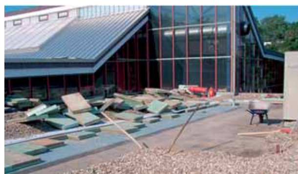
Fig. 1: Intervento di risanamento con Styrodur® C.
