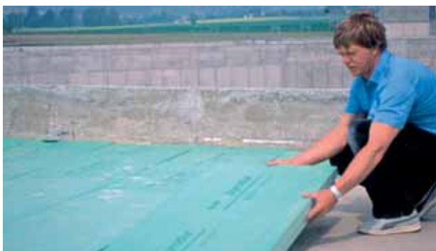
Fig. 4: Posa di uno strato isolante di Styrodur® C sul tetto.
