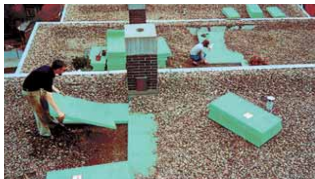
Fig. 5: Posa dello strato isolante sotto la ghiaia.
