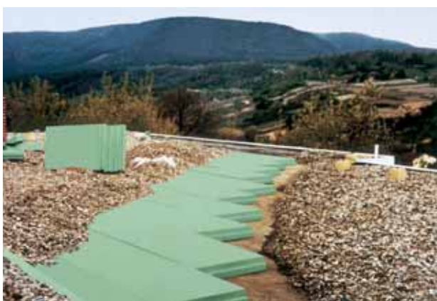
Fig. 6: Tetto rovescio risanato come struttura di tetto-plus.
