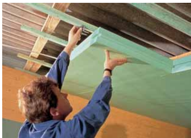
Fig. 12: Applicazione di lastre di Styrodur C.
