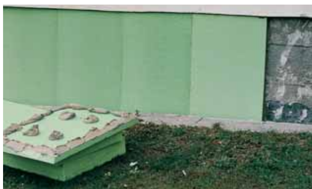
Fig. 21: Risanamento di una vecchia costruzione; incollaggio di lastre Styrodur 2800 C con procedura di giunzione a punti sul bordo.
