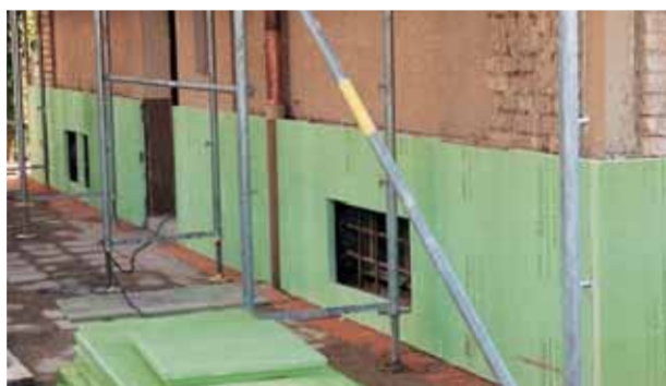
Fig. 19: Successivo isolamento dello zoccolo con Styrodur® 2800 C.
