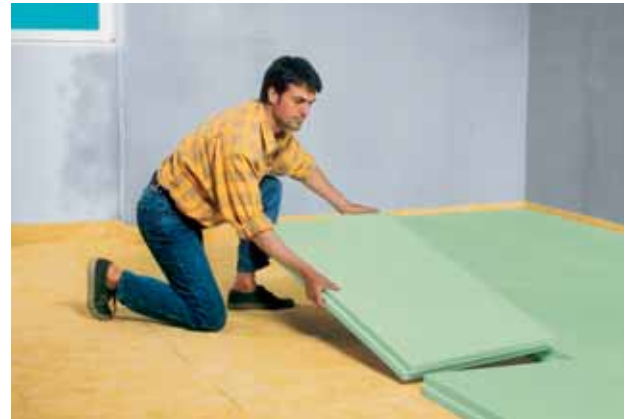
Fig. 28: Isolamento del pavimento e isolamento anticalpestio di locali abitativi con Styrodur C.
