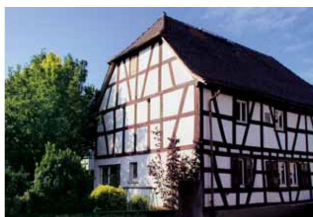
Fig. 2: Impiego di Styrodur C nell'ambito del progetto di risanamento di un edificio con travi a tralicci, in collaborazione con la Deutschen Energieagentur.
