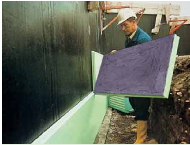
Fig. 6: Applicazione delle lastre di Styrodur C sulla parete esterna della cantina.
