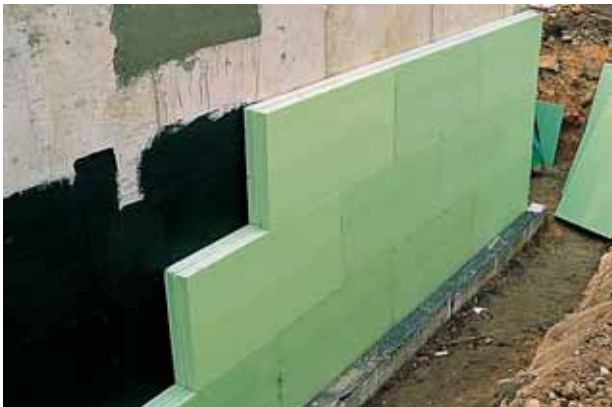
Fig. 5: Posa delle lastre di Styrodur® C allineate.
