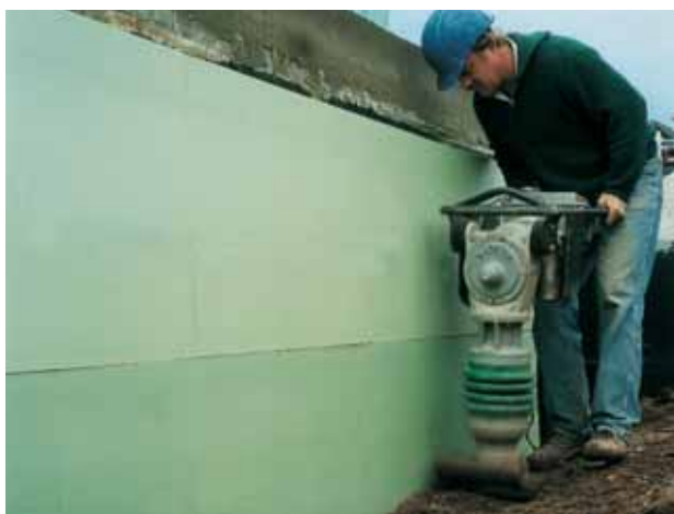
Fig. 26: Riempimento a strati dello scavo di fondazione e costipazione meccanica.
