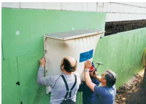
Fig. 3: Isolamento perimetrale con Styrodur® C.
