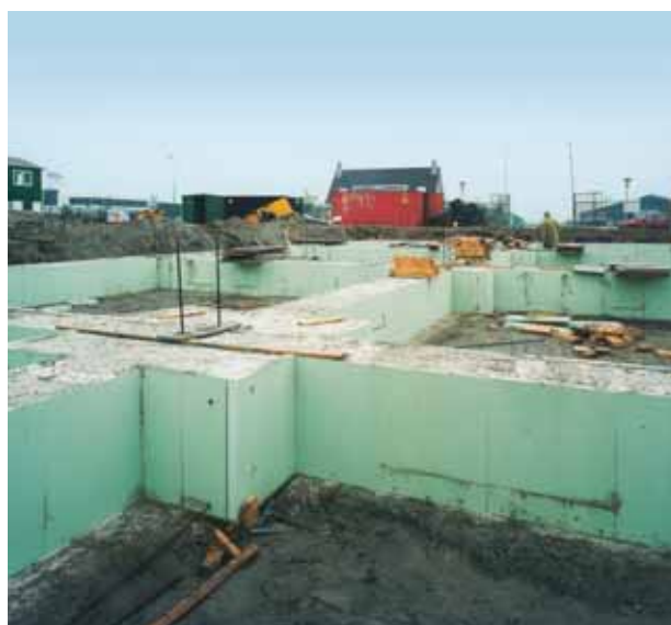
Fig. 16: Lastre di Styrodur 2800 C installate nella cassaforma.
