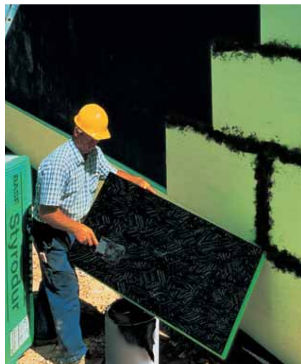
Fig. 25: Incollaggio su tutta la superficie delle lastre di Styrodur® C e degli spigoli nonché stuccatura dei giunti tra le lastre nella zona della falda acquifera.
