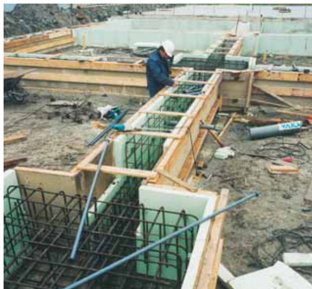
Fig. 15: Cassaforma con Styrodur 2800 C.
