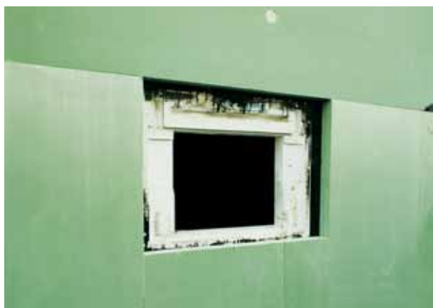
Fig. 4: Particolare dell'intervento di isolamento con Styrodur C.
