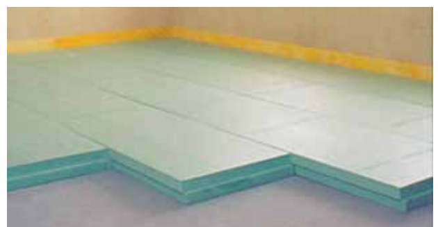
Fig. 18: Isolamento del pavimento con Styrodur C.
