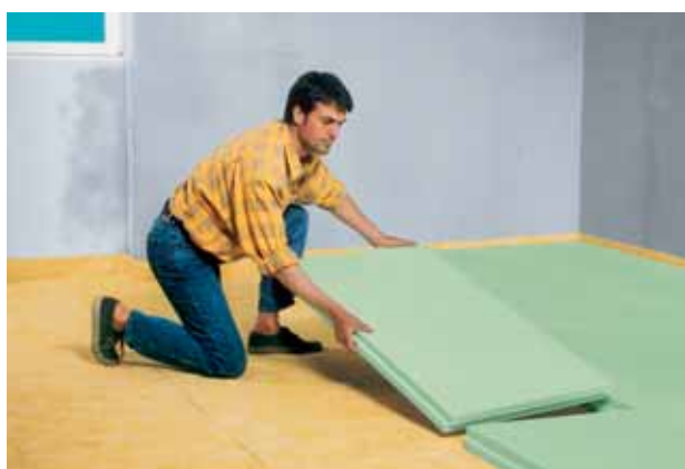
Fig. 20: Isolamento del pavimento con isolamento anticalpestio in EPS elasticizzato di locali abitativi con Styrodur® C.
