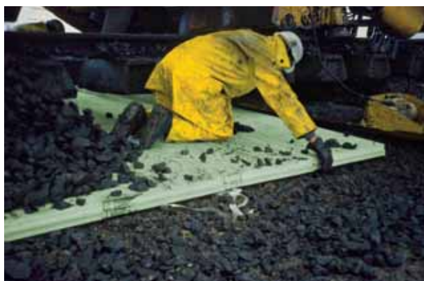
Fig. 9: Posa di Styrodur C nella massicciata ferroviaria.
