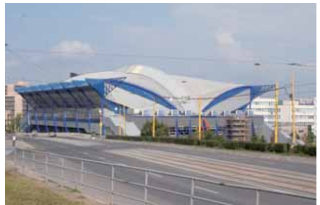
Fig. 17: Riferimento: Steel Arena a Košice (Slovacchia). Nel nuovo palazzetto per hockey su ghiaccio è stato posato Styrodur C sotto alla superficie della pista. Qui avrà luogo il Campionato mondiale di hockey sul ghiaccio nel 2011.
