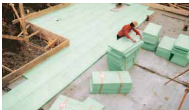
Fig. 4: Posa di lastre di Styrodur C.
