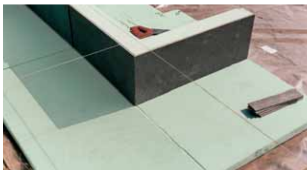
Fig. 3: Isolamento di una piastra di fondazione con Styrodur® C.
