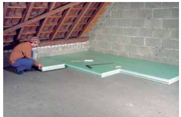
Fig. 2: Isolamento del sottotetto con Styrodur C.
