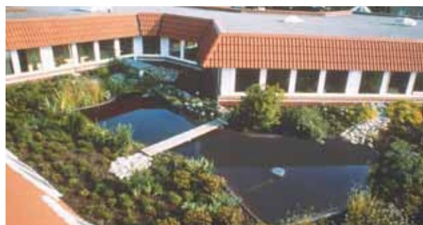
Fig. 6: Tetto verde a terrazza calpestabile con irrigazione a raccolta in stagni artificiali su una struttura di tetto rovescio con strato drenante di ghiaia su tutta la superficie.
