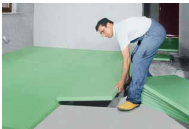
Fig. 19: Isolamento del pavimento della cantina.
