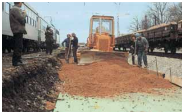
Fig. 8: Protezione antigelo nella massicciata ferroviaria con Styrodur C estremamente resistente alla compressione.
