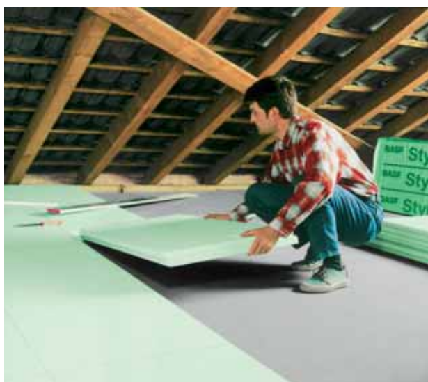
Fig. 10: Isolamento di un sottotetto con Styrodur® C.
