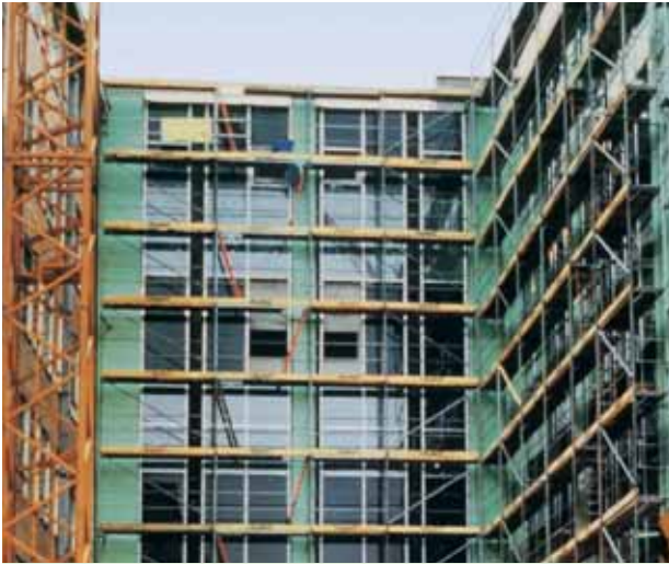
Fig. 7: Isolamento di ponti termici con Styrodur® 2800 C.
