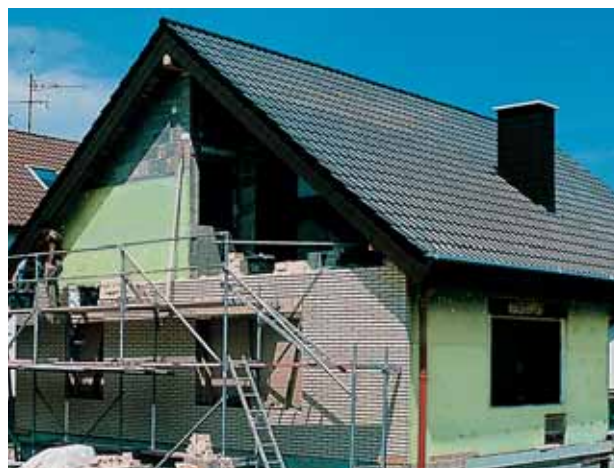
Fig. 39: Isolamento in intercapedine con Styrodur C.
