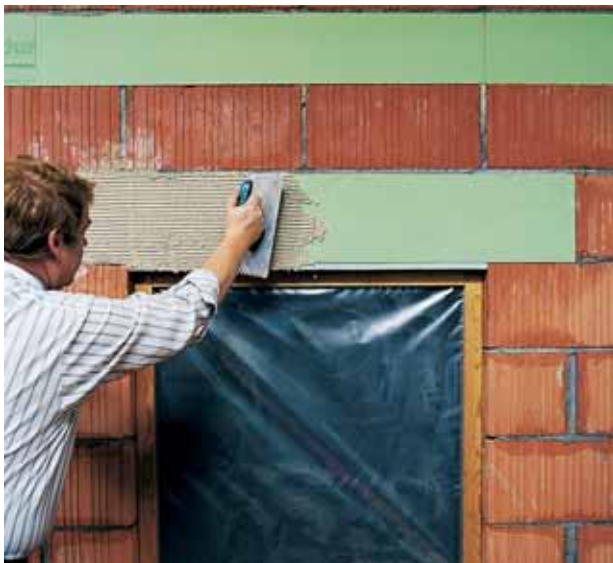
Fig. 20: Architrave della finestra nella muratura da isolare termicamente; stesura orizzontale dello strato adesivo per l'intonaco.
