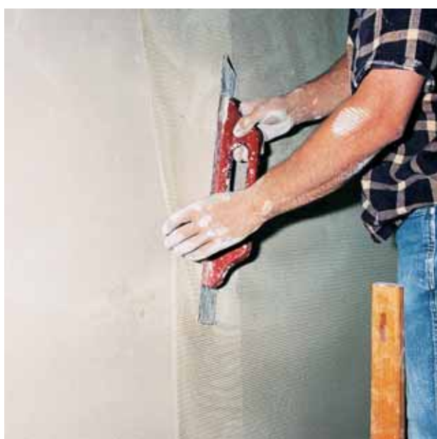
Fig. 33: Posa su tutta la superficie della rete di armatura in fibra di vetro. I teli di rete sono sovrapposti di circa 100 mm.
