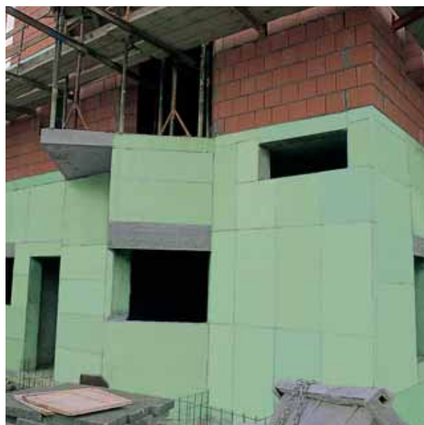
Fig. 25: Isolamento di un pianterreno con lastre di Styrodur 2800 C.
