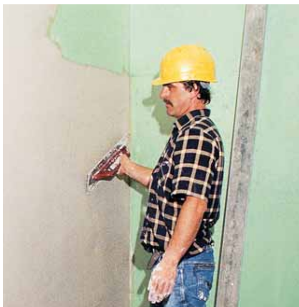
Fig. 32: Stesura del primo strato di intonaco adesivo a base di gesso; spessore dell'applicazione 10 mm.
