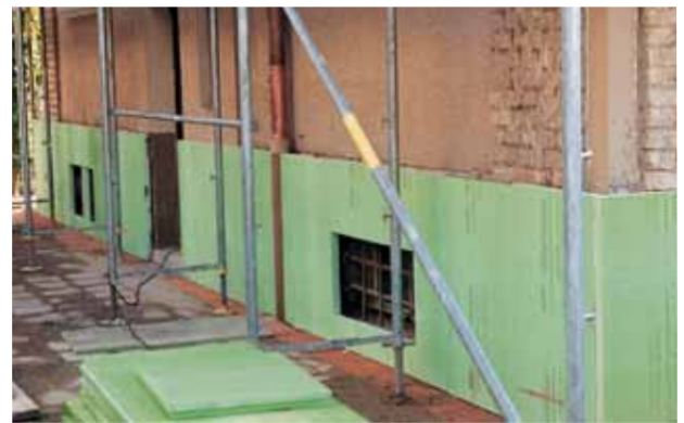
Fig. 17: Successivo isolamento dello zoccolo con Styrodur 2800 C.
