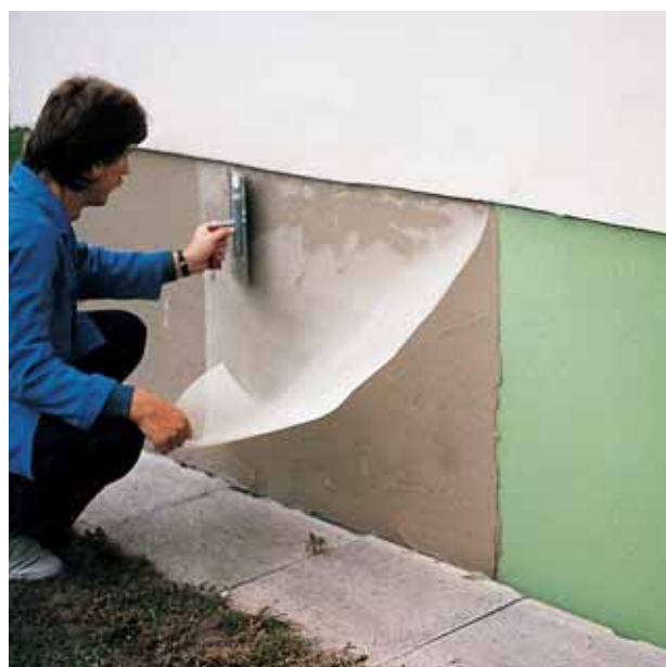
Fig. 29: Inserimento della rete in fibra di vetro nell'intonaco di fondo dello strato isolante dello zoccolo.
