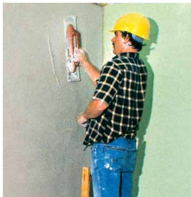
Fig. 34: Stesura del secondo strato di intonaco, spessore di circa 5 mm. L'applicazione dell'intonaco avviene bagnato su bagnato.
